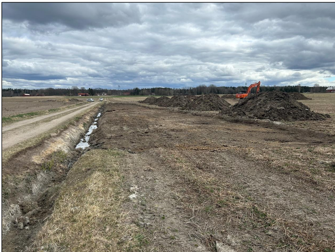
Platsen på Urban Larssons mark där fosfordamm ska anläggas. Foto: Anna Eklund
