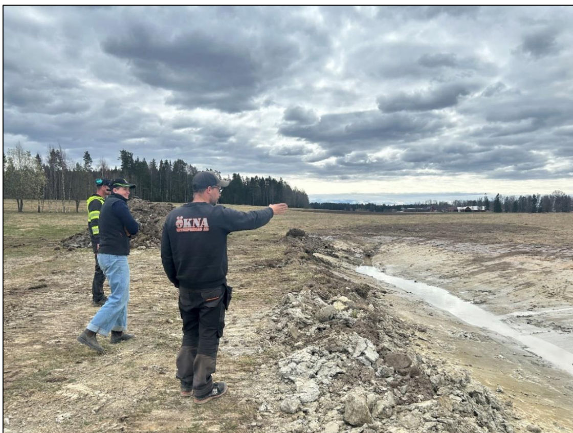
"Där ska dammen ligga" – Arbetsledare Kalle Nilsson är rak och tydlig med kommunikationen i arbetet, och det behövs – anläggande av damm är inget att leka med! Foto: Anna Eklund
