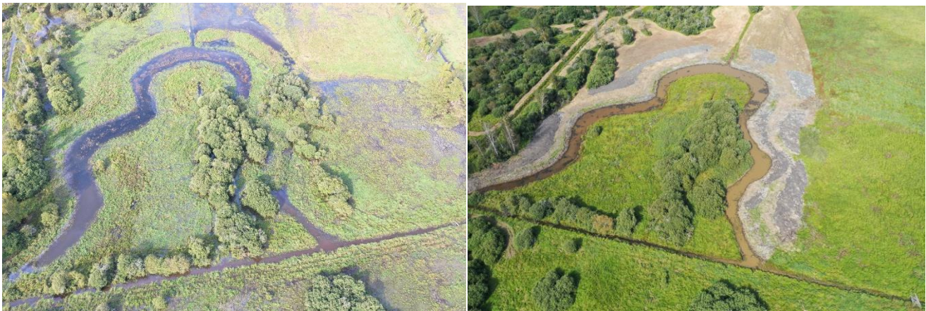
Figur 3 Dammen Örstkärret före åtgärd till vänster och efter åtgärd till höger. Foto: Norconsult
