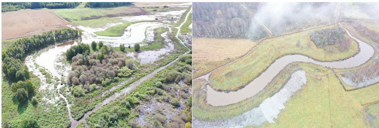
Figur 4 Lisselsjödammen före åtgärd till vänster och efter åtgärd till höger. Foto: Norconsult
