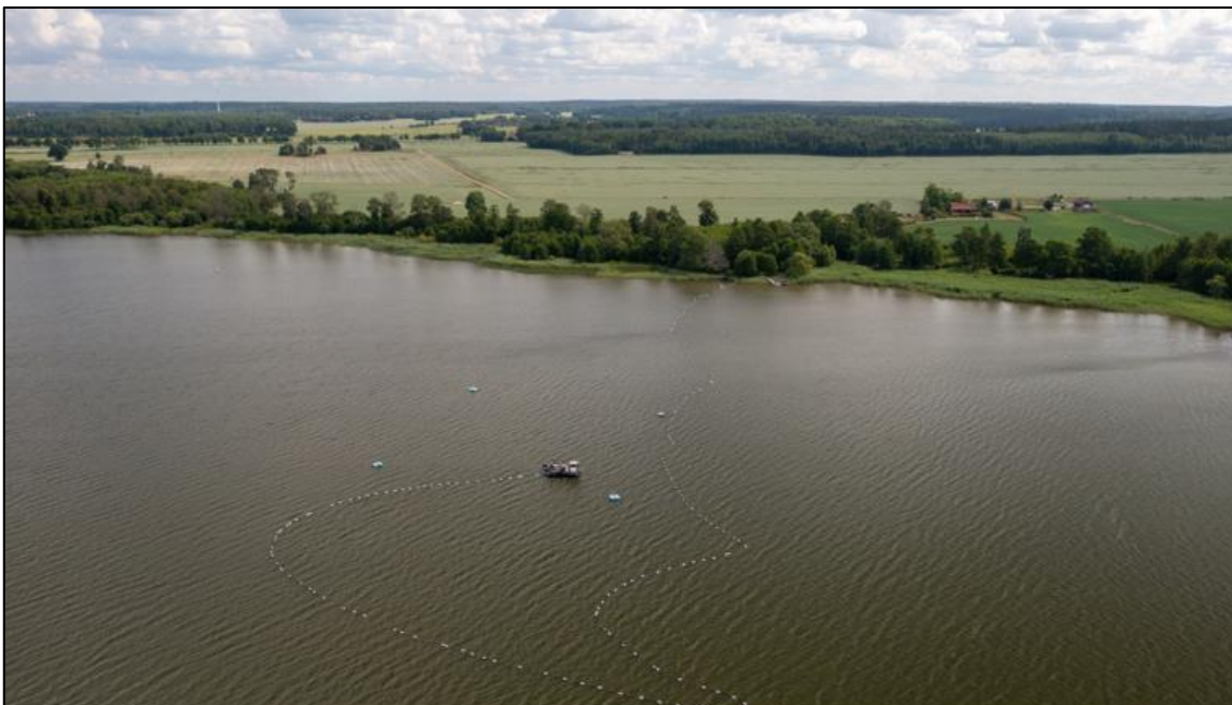
Bild från ovan över flotte med muddringsverk och slang för transport av sediment till land. Muddring har bedrivits sen 2022 av Tecomatic. Mudderverket drivs med elektricitet och rör sig längs en vajer mellan 4 hörnbojar som syns mitt i bild. Foto: Johan Hammar
